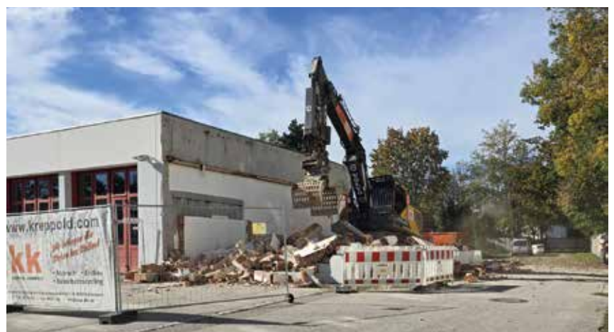
rechts: als erste sichtbare Maßnahme erfolgte der Abriss des Oldtimer-Anbaus
